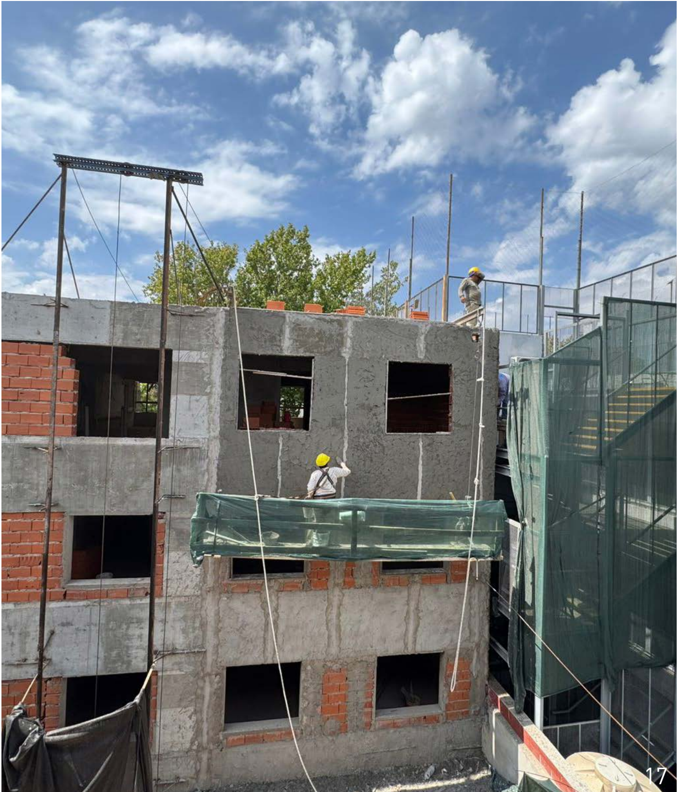
17. Pulmón - Comienzo de revoque exterior del volumen del frente.
