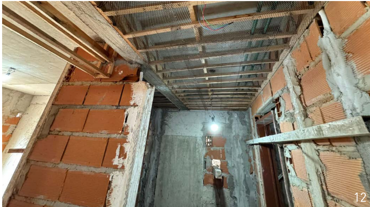
10 - Dormitorio principal - Armado de cieloraso 1ro y 2do contrafrente.
