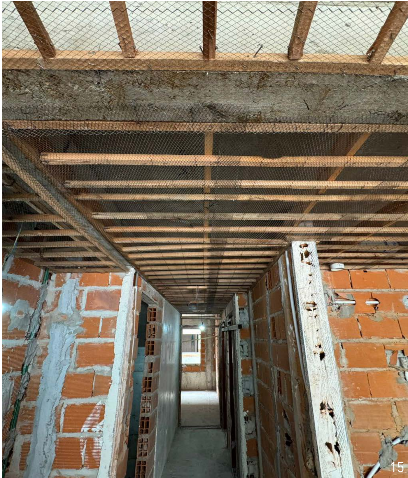
15. Living y Pasillo interior - armado de cieloraso 1ro y 2do Contrafrente
