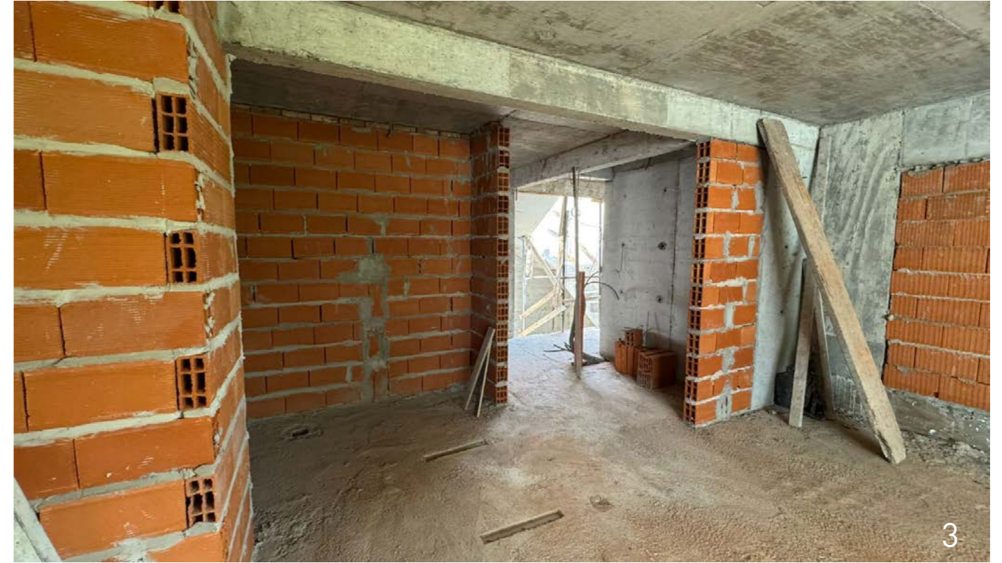
3 y 4 - Living comedor - Mampostería 3er piso.
