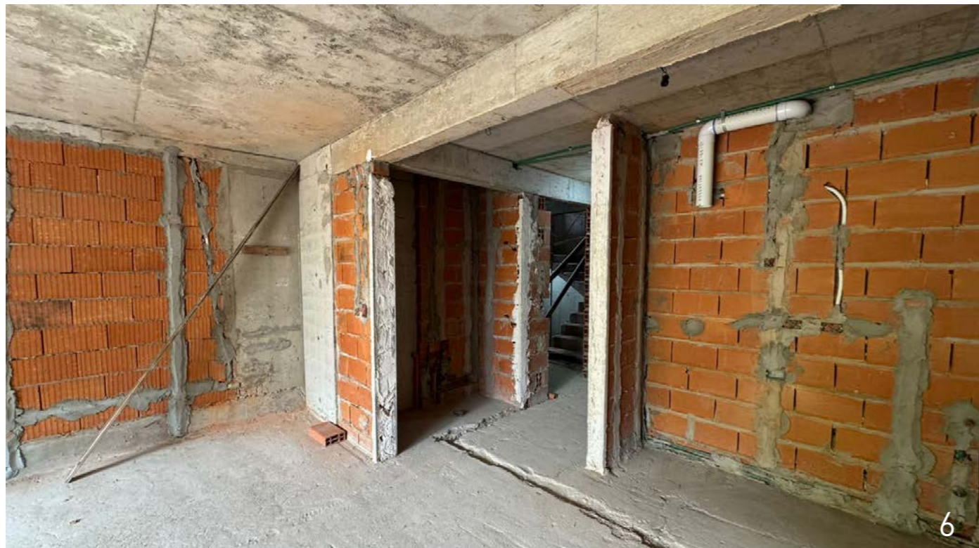
6- Cocina y lavadero: Contrapiso, carpeta y mampostería 1ro y 2do piso.
