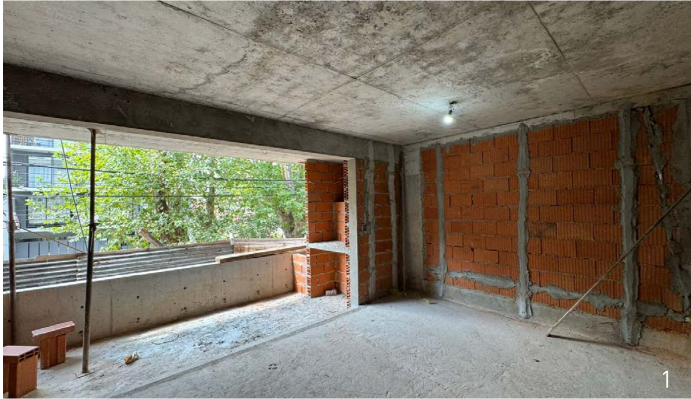
1 y 2 - Living: Contrapiso, carpeta y mampostería 1ro y 2do piso.
