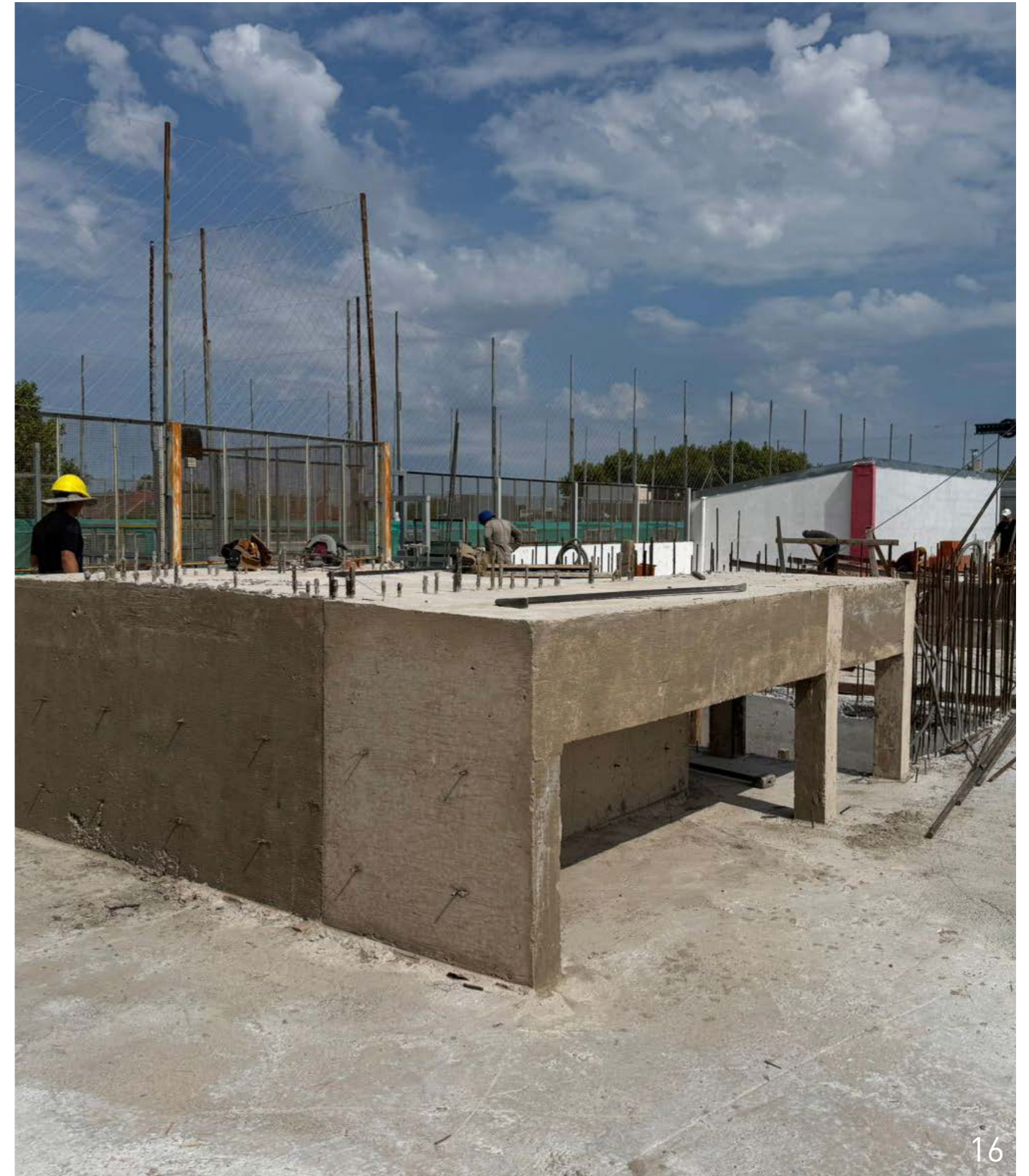
16. Azotea - Estructura sala de máquina.
