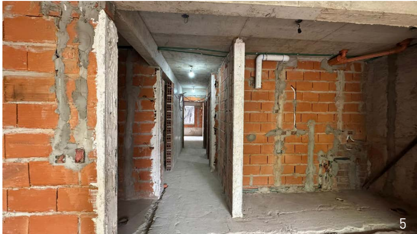
6- Cocina y lavadero: Contrapiso, carpeta y mampostería 1ro y 2do piso.
