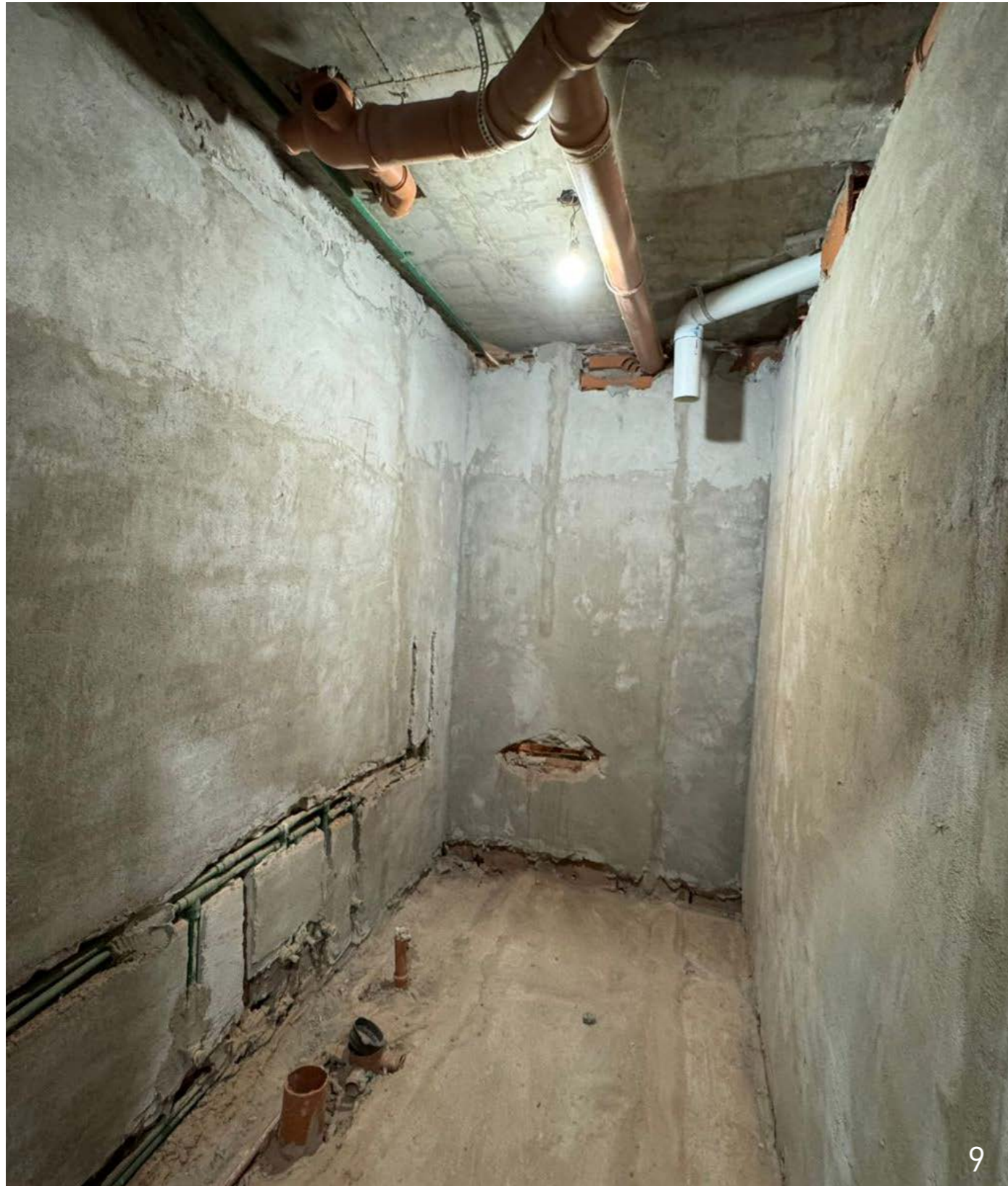
9 - Baño Principal: Revoque e instalaciones 1ro y 2do piso.
