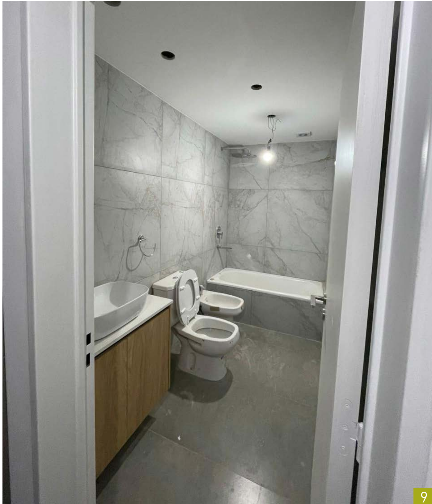
9. Baños Principales - Colocación mesadas, bachas y griferías.
