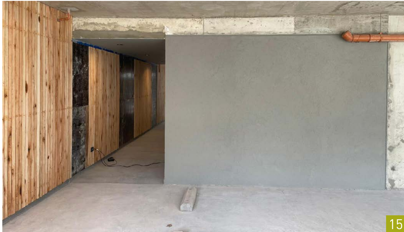
15 y 16 - Colocación y pintura del revestimiento de madera en P.B..
