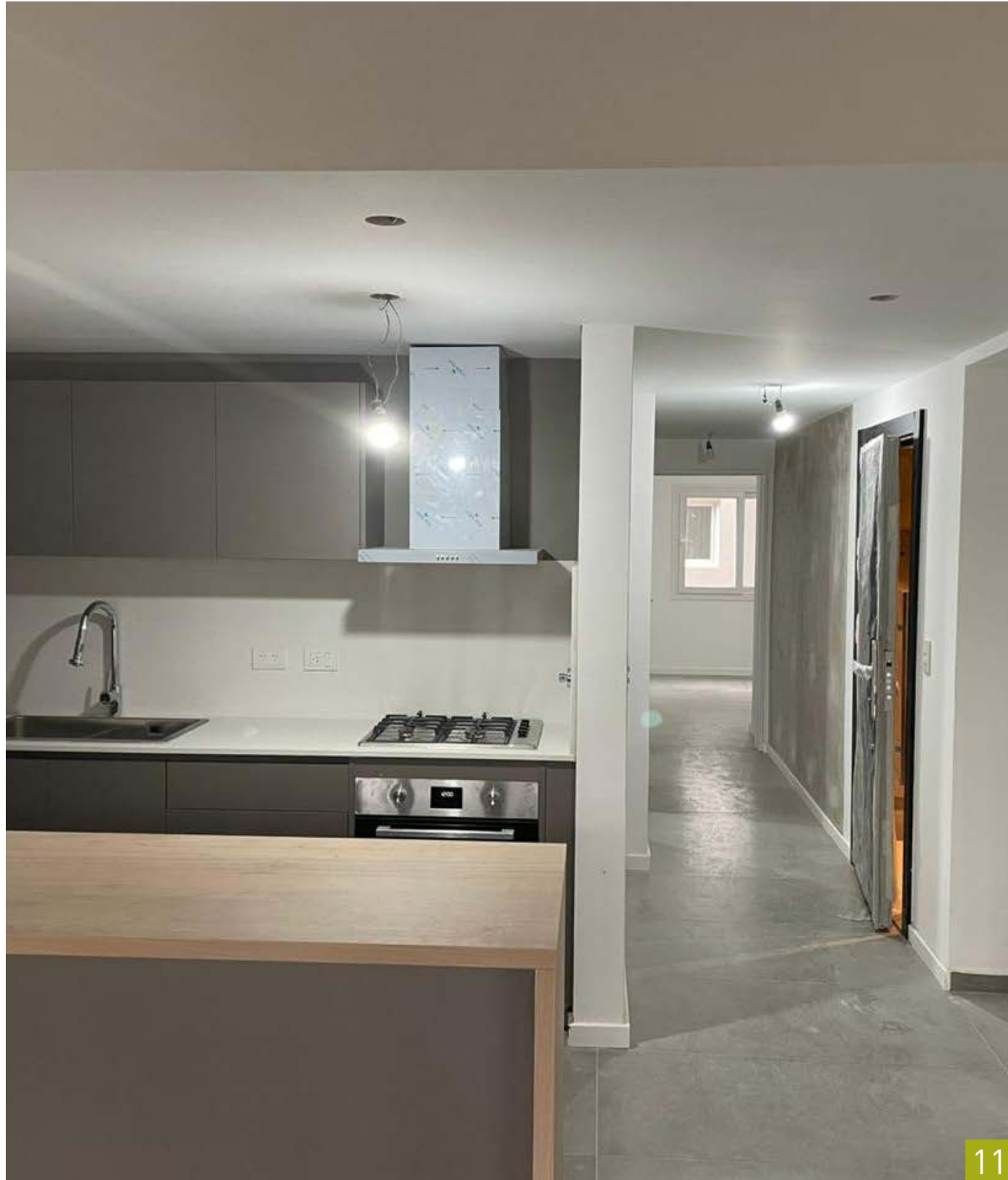
11 - Colocación de barras, mesadas y muebles de cocina.
