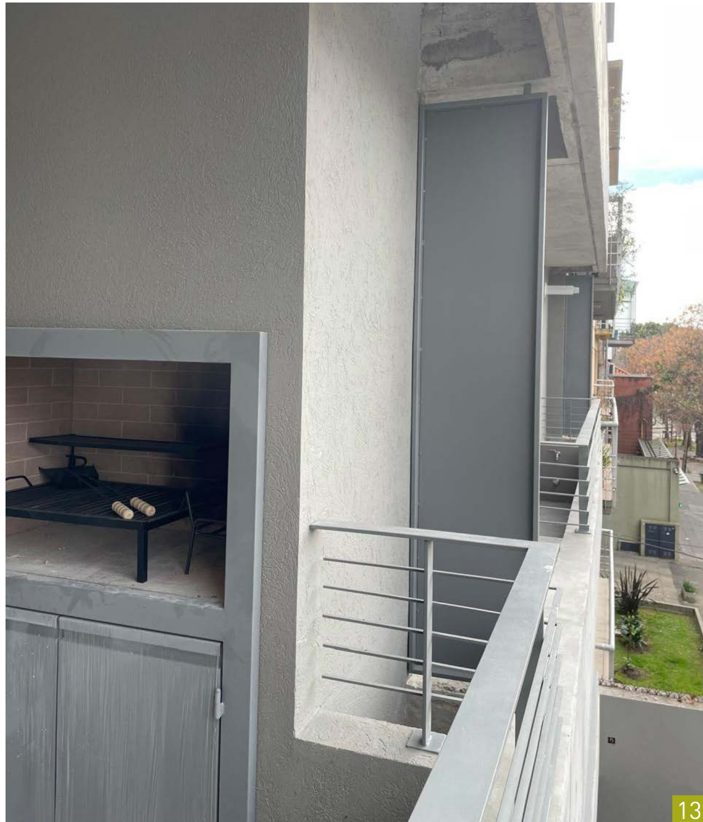
13 - Herrería - Colocación de divisores y accesorios de parrilla
