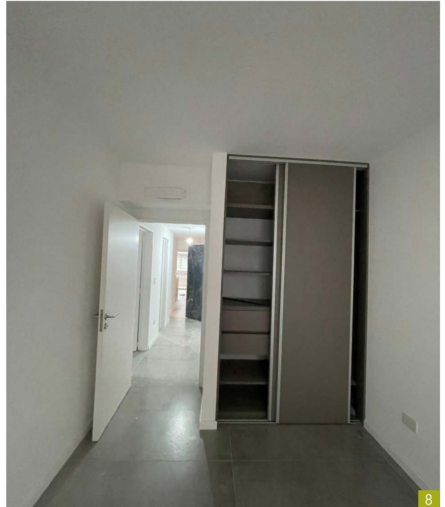
8 - Colocación de placares en dormitorios.
