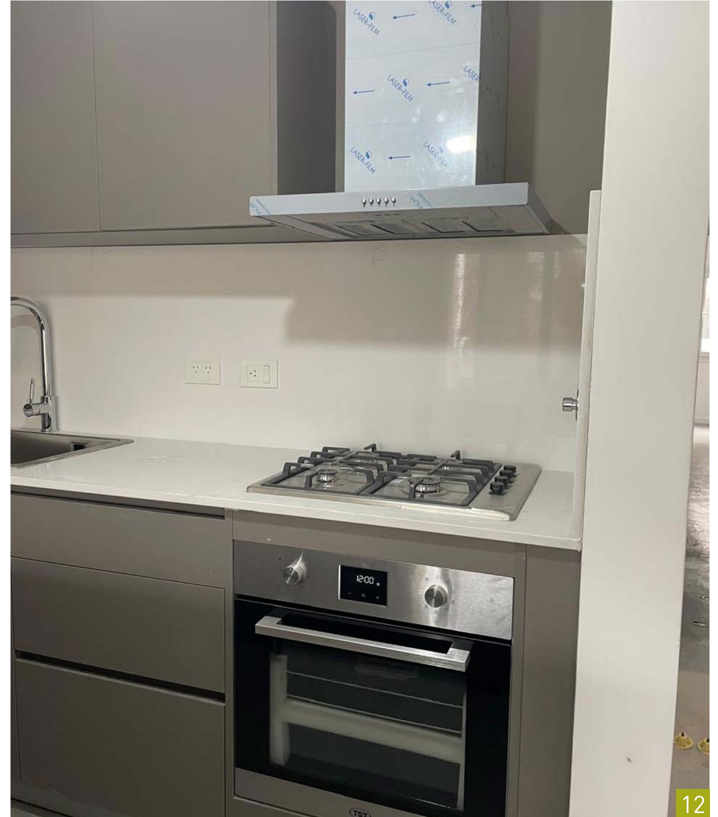
12 - Colocación de campana.
