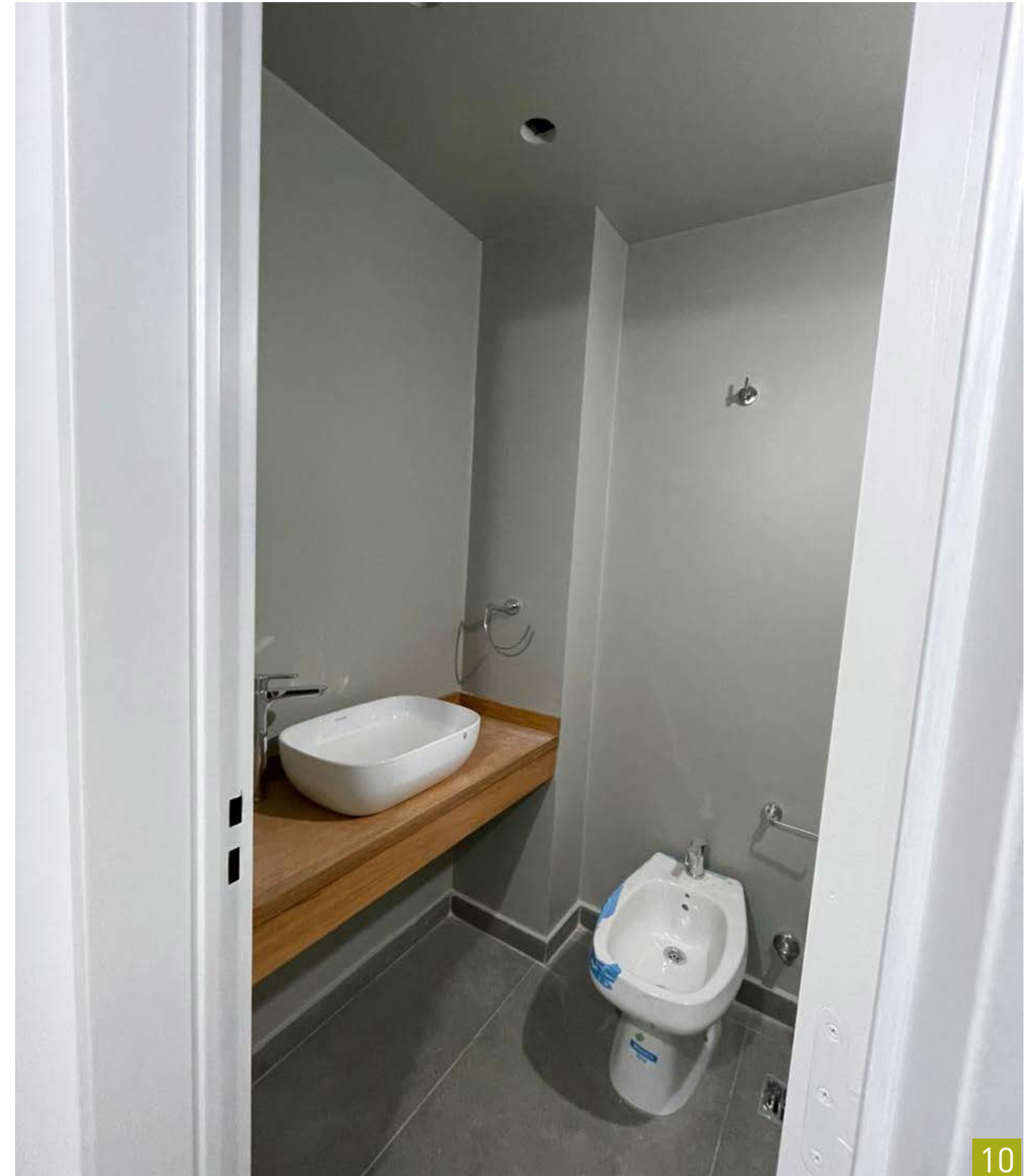
10 - Baños secundarios - Colocación mesadas, bachas y griferías.
