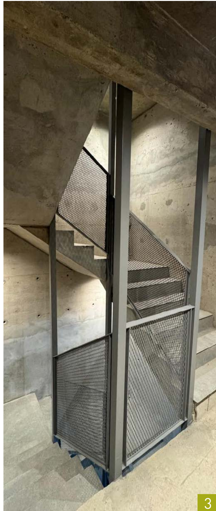
2 - Colocación de herrajes en puertas entrada. 3 - Colocación de barandas en escaleras.
