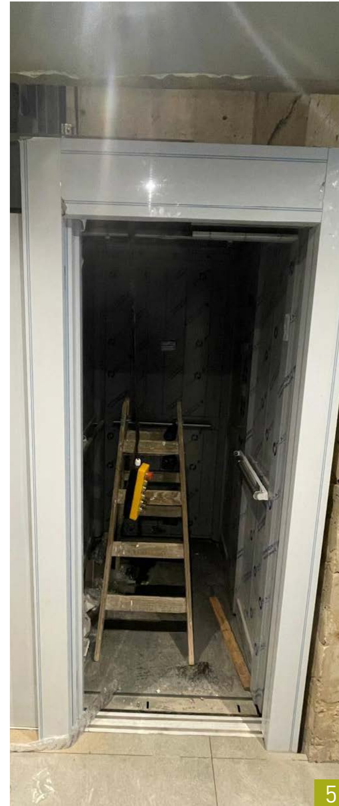
5 y 6 - Colocación de marcos e instalación de ascensor.
