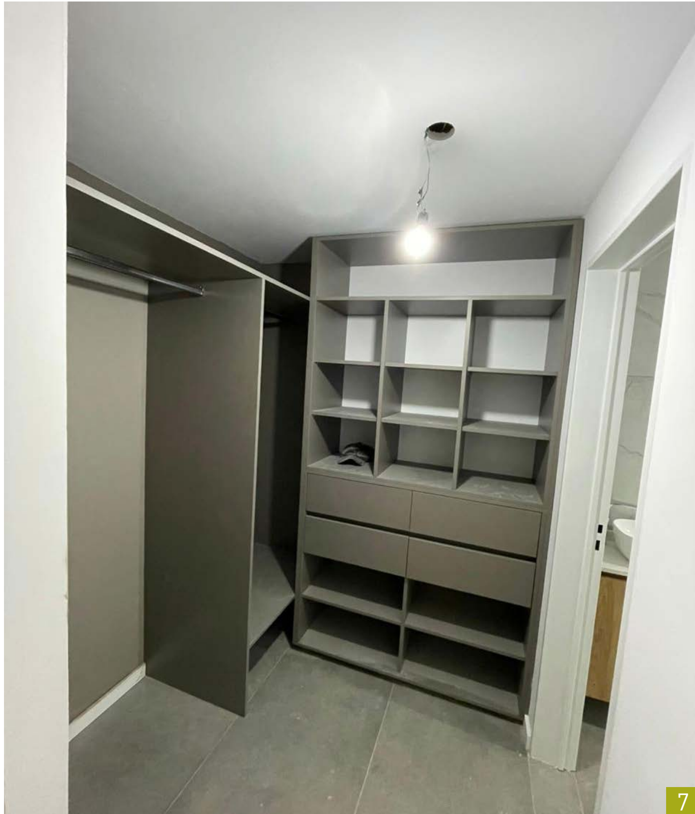
7 - Colocación de placares y vestidores
